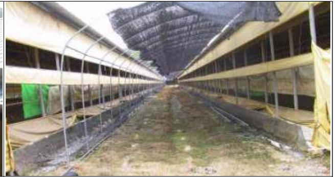
<계사 서향에 그늘막 설치>
