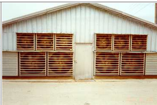
<계사 환기팬 설치>
