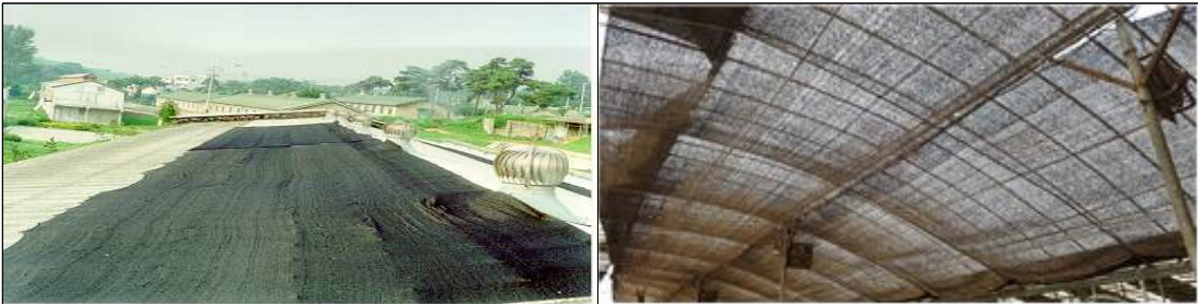
<축사지붕 및 축사 내 차광막 설치>
